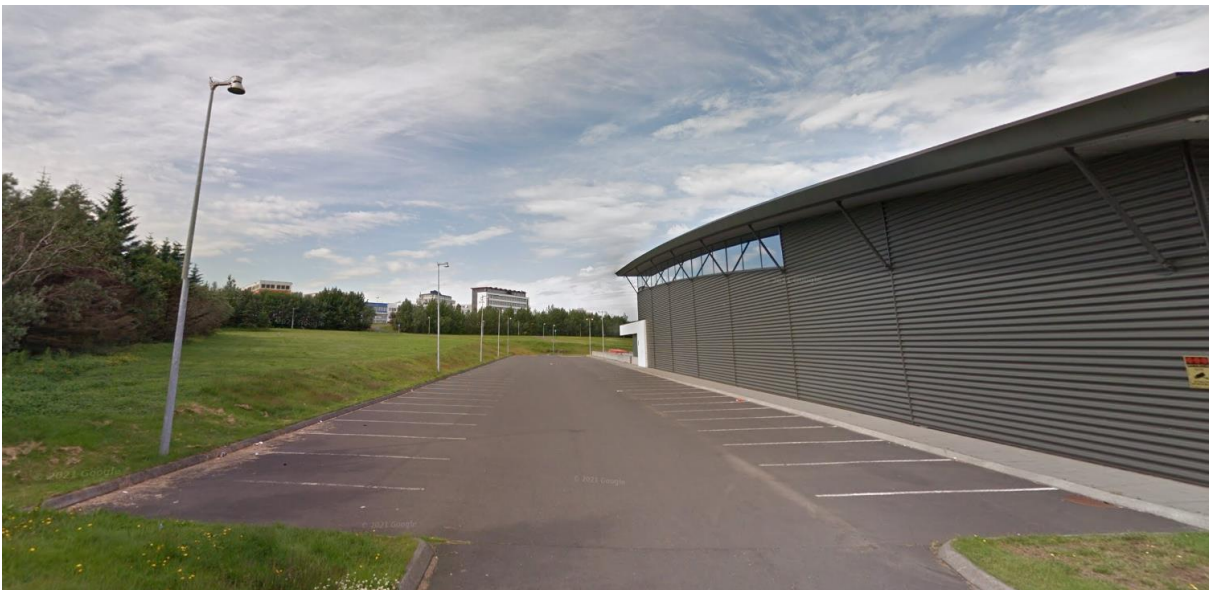
Mynd 6.1 Horft yfir framkvæmdasvæðið, sunnan við Laugardalshöllina. Mynd: Google maps.
